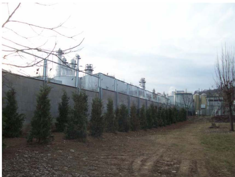
Figura 6 - La barriera realizzata come intervento di risanamento acustico a seguito dell'indagine con l'Acoustic Camera
